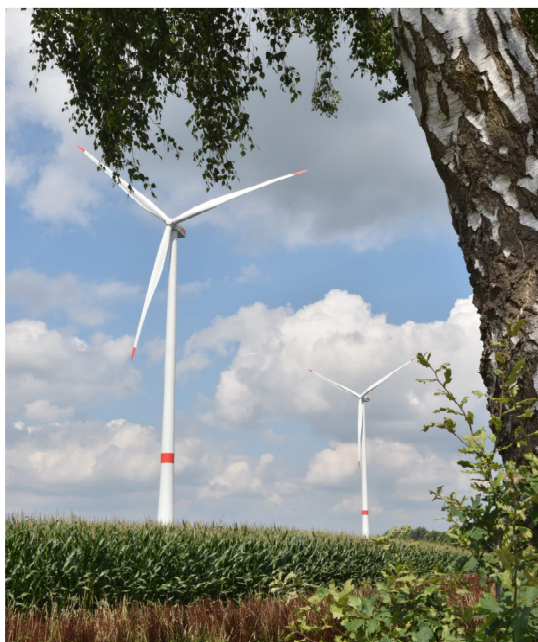
Die beiden Windenergieanlagen des Bürgerwindparks Recke
